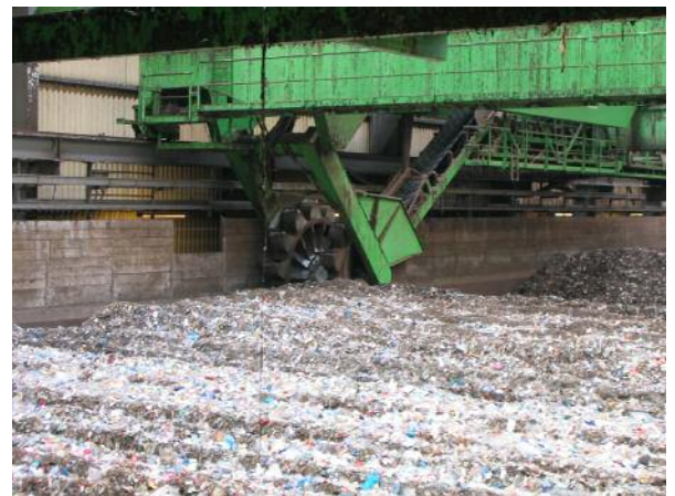
腐化车间和搬运设备
